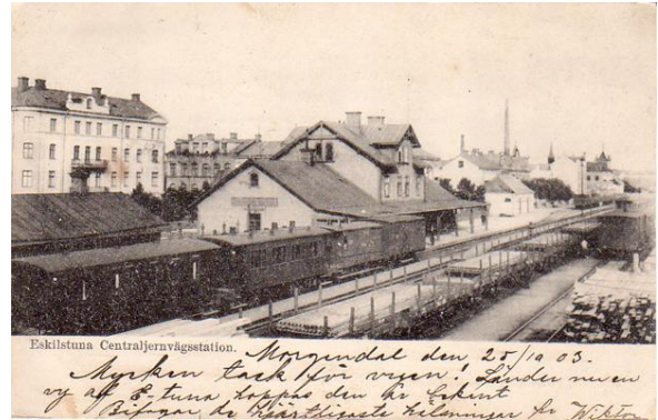
Centraljärnvägsstationen i början av 1900-talet.
